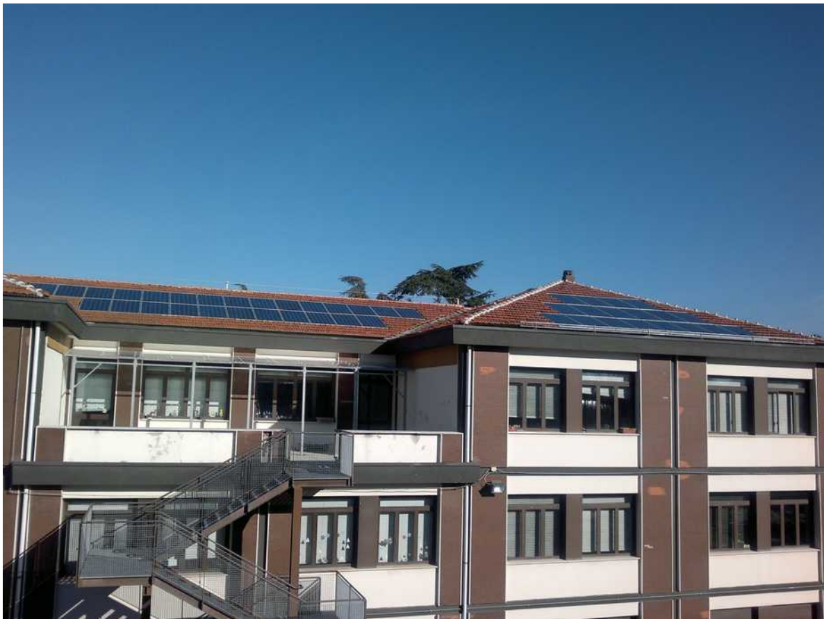
I pannelli fotovoltaici sulle falde centrale e laterale SE
